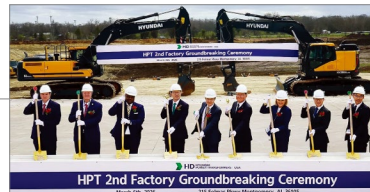
북미 생산법인 제2공장 기공 *초고압 변압기 생산능력을 기존 대비 50% 확대 계획
